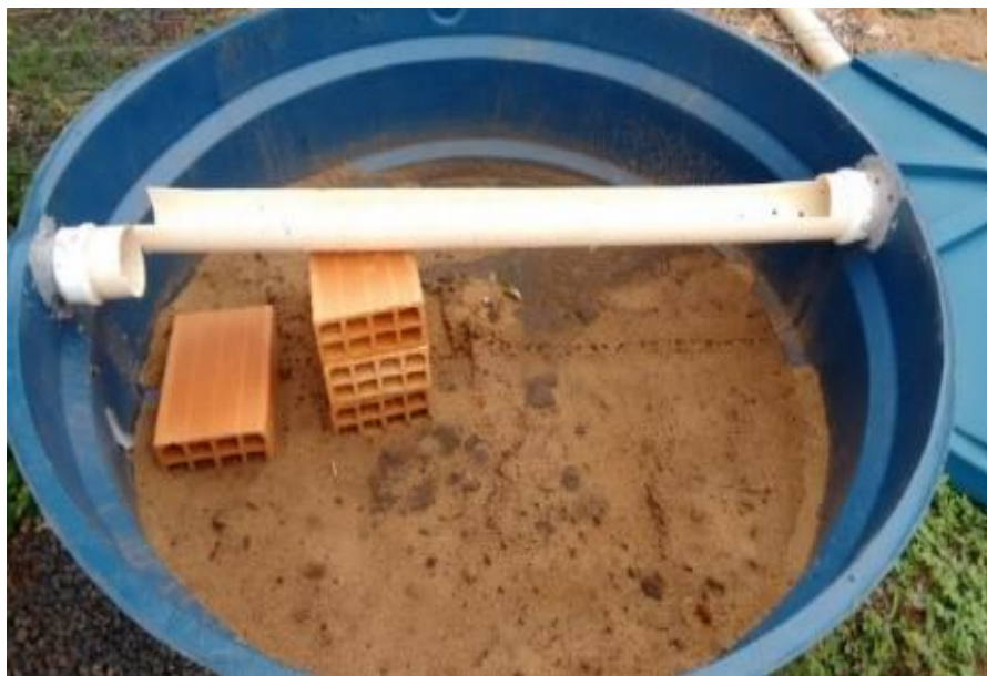
Figura 16. WCFSSV 2 em fase de construção. Fonte: (FELIX, 2018).
